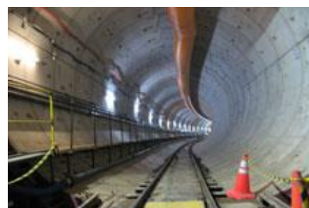
トンネル掘削が完了している区間。(JICA)
